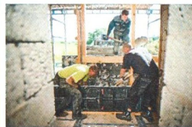
Fyllning. Blandningen av hampa och kalk fyls snabbt i väggar som torkar på 24 timmar.
