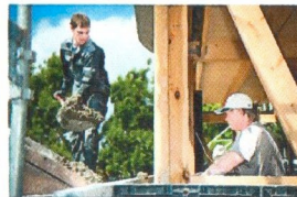
Fyllning. Byggarbetaren Pontus Görné och inlåtaren Dag Melkersson skapar väggar av hampakalk som torkar på 24 timmar.
